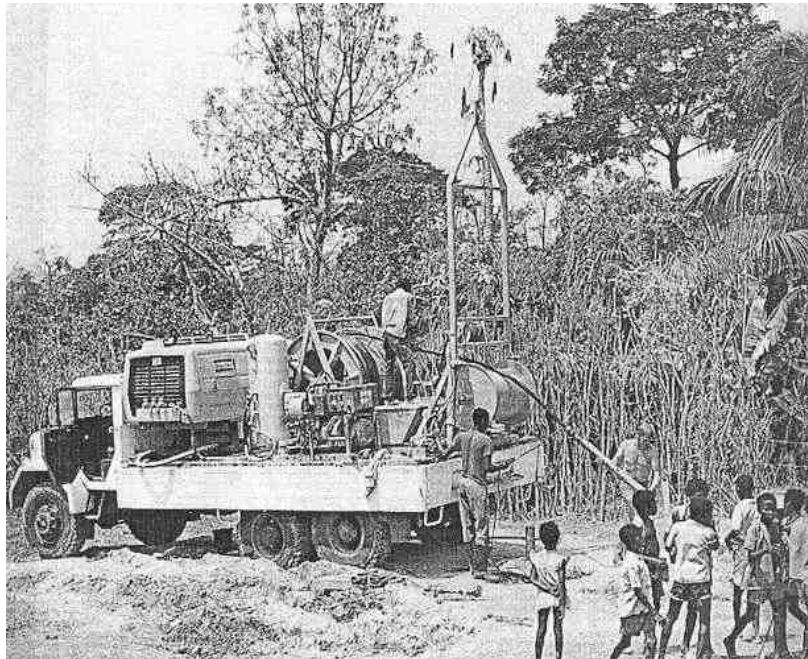
Abb. 38: Einbringen der Pumpe in einen Brunnen in Ghana (/16/ Sandomeer, 1985)
